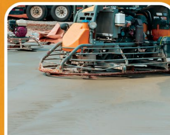
CONCRETO PARA PISO INDUSTRIAL
